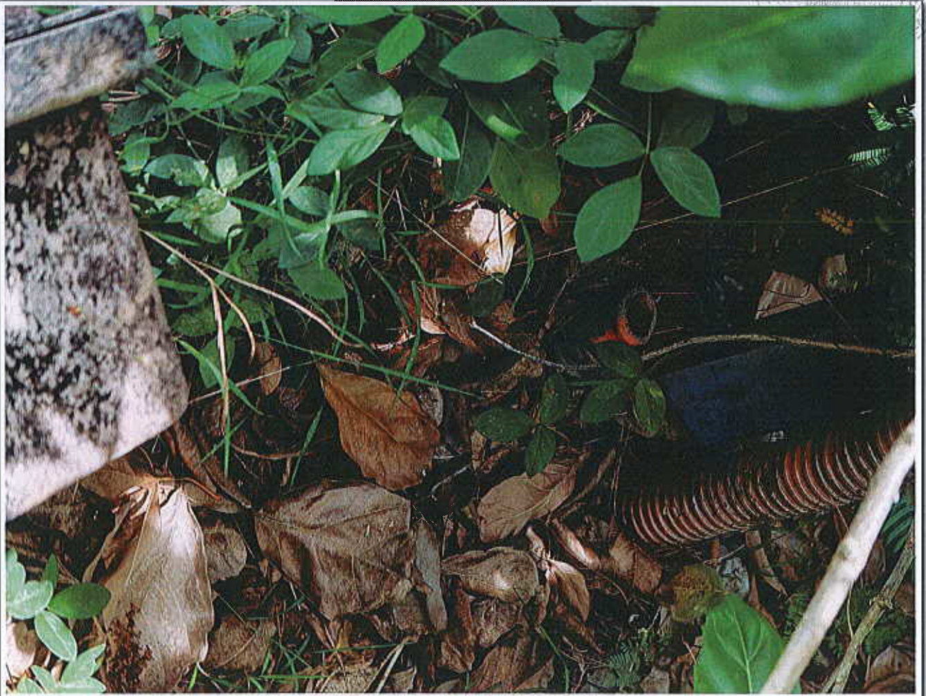
Descriptif Parcelle AZ 485 PETIT CANAL - Photo 10
